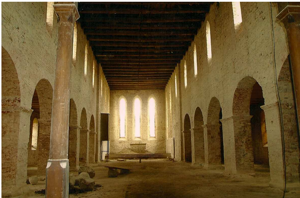
Kirche St. Marien der Innenraum bei der Renovierung (2009)
