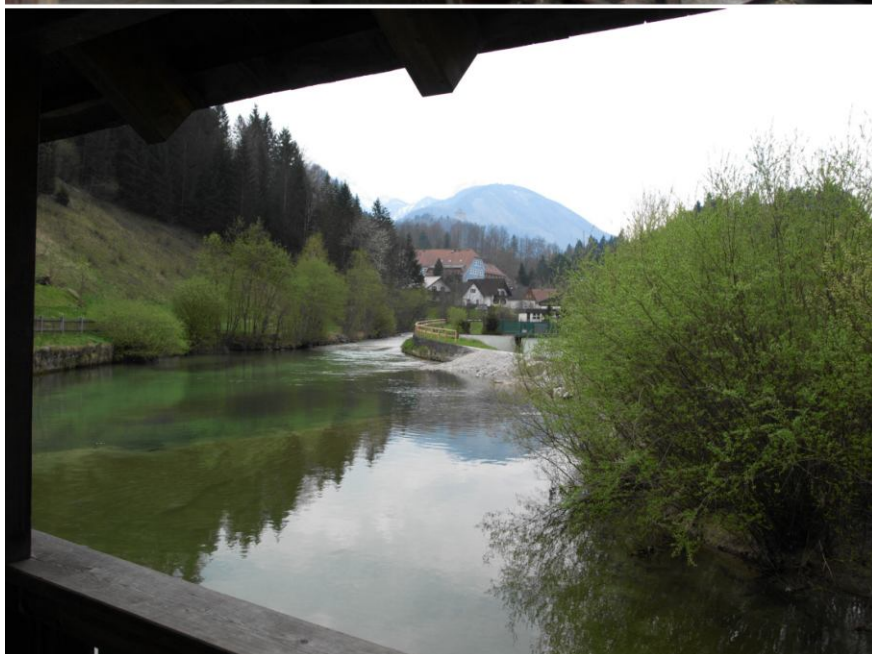
Etwas oberhalb des ehemaligen Standortes des Drahtzuges ist heute noch eine stattliche Wehranlage zu sehen. (Aufnahmen: April 2010)
