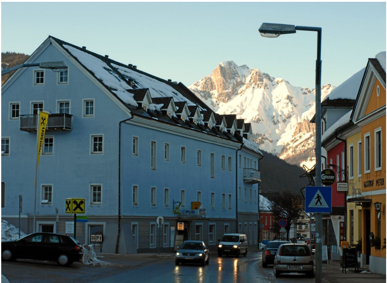
Haus, vormals Hauptstraße 30
